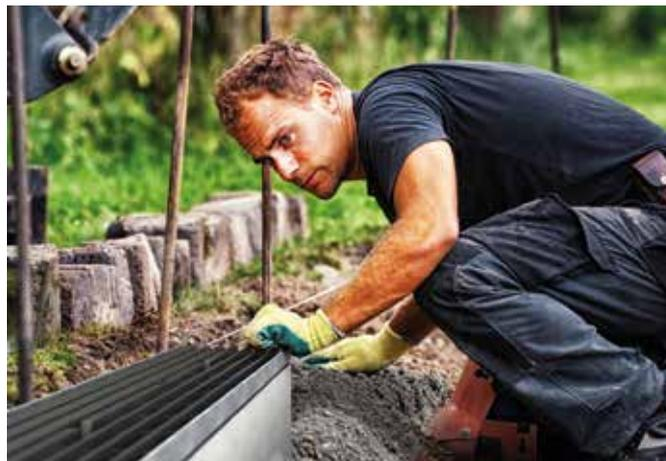
ge Entwässerungssystem Filcoten wiederum vereint die Vorteile von Beton und einer neuartigen Produktionstechnologie. Die Rinnen sind um bis zu 70 Prozent leichter als herkömmliche Systeme und komplett recycelbar. Auch hier sind für die unterschiedlichen Anwendungsbereiche die entsprechenden Produkte mit einer großen Auswahl an Abdeckungen und Zubehör verfügbar.
