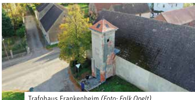
Trafoshaus Frankenheim (Foto: Falk Opelt)
