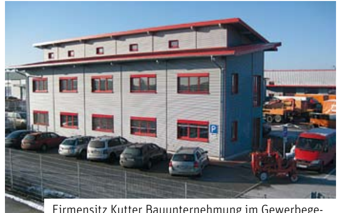
Firmensitz Kutter Bauunternehmung im Gewerbegebiet Frankenheim
