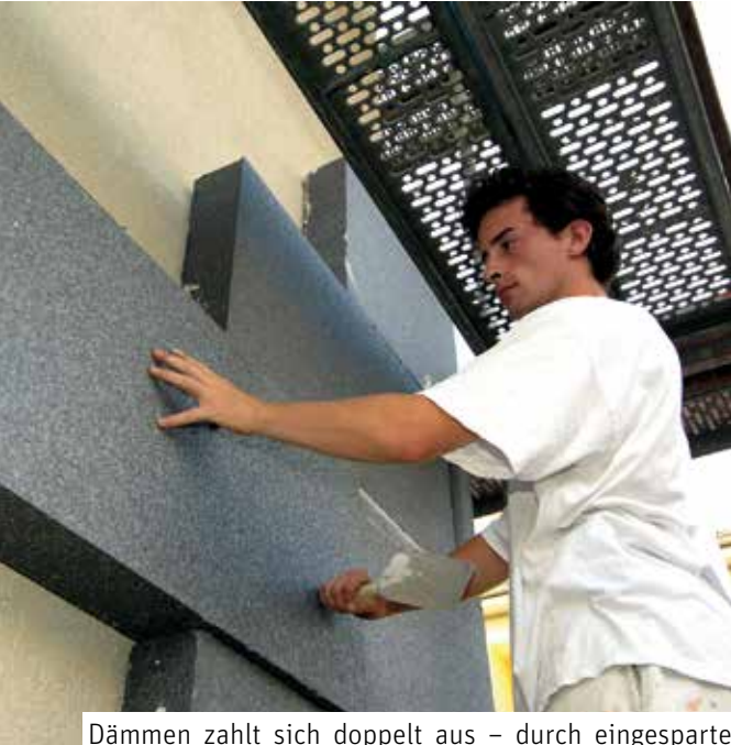
Dämmen zahlt sich doppelt aus – durch eingesparte Heizkosten für den Verbraucher ebenso wie für die Umwelt. (Foto: djd/IVH Industrieverband Hartschaum e. V.)
