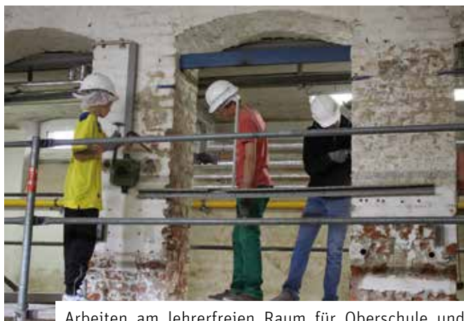
Arbeiten am lehrerfreien Raum für Oberschule und Gymnasium
