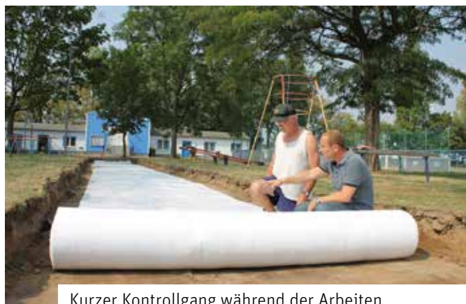
Kurzer Kontrollgang während der Arbeiten
