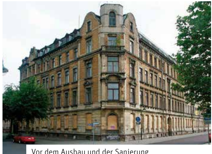
Vor dem Ausbau und der Sanierung
