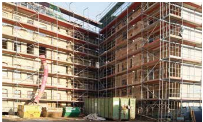
Vor dem Ausbau und der Sanierung
