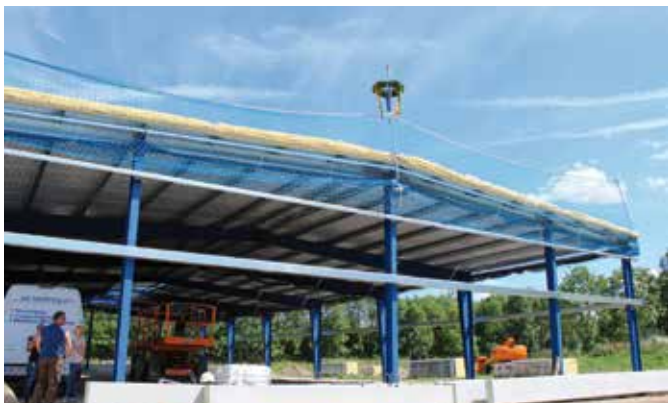
Das Grundgerüst steht, Fertigstellung für Ende Oktober avisiert (Foto: Stadt Markranstädt)
