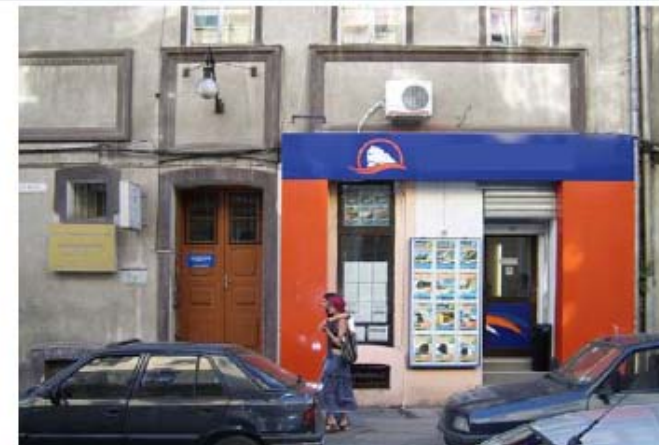
FALSCH! Die Werbung dieses Geschäfts verdeckt Elemente der Fassade. Sie ist zu bunt und mit ungeeigneten Materialien ausgeführt.
