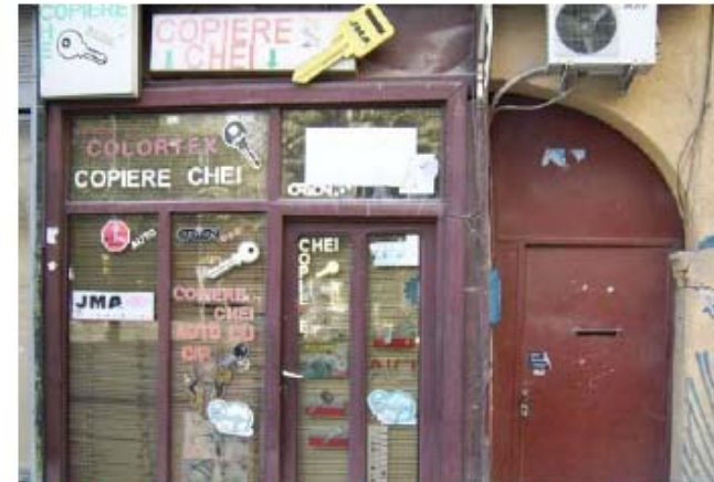
FALSCH! Eine historische Durchfahrt wurde rücksichtslos in einen Laden umgebaut, ohne Bezug zur restlichen Fassade.
