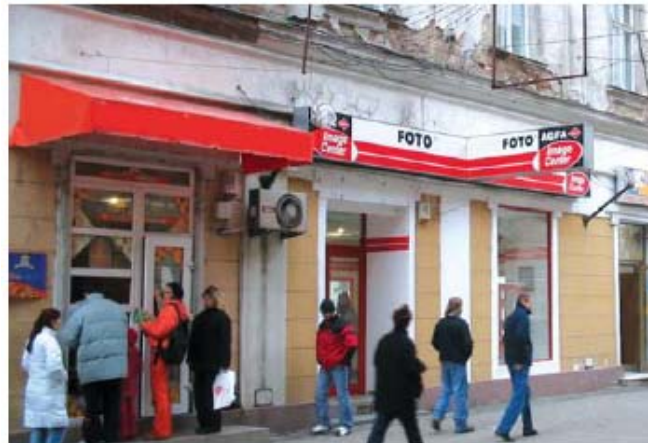
FALSCH! Die Werbung und das Vordach kragen zu weit in den Straßenraum. Sie sind in ungeeigneten Materialien ausgeführt.
