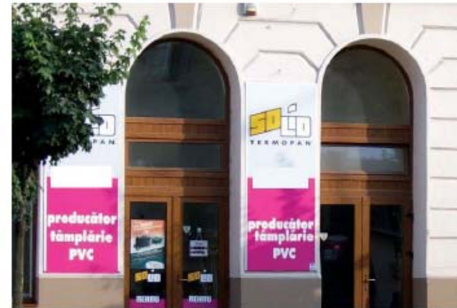
FALSCH! Dieses Geschäft nutzt nicht nur die Schaufenster, sondern hat auch Werbeflächen direkt auf die Fassade aufgebracht.
