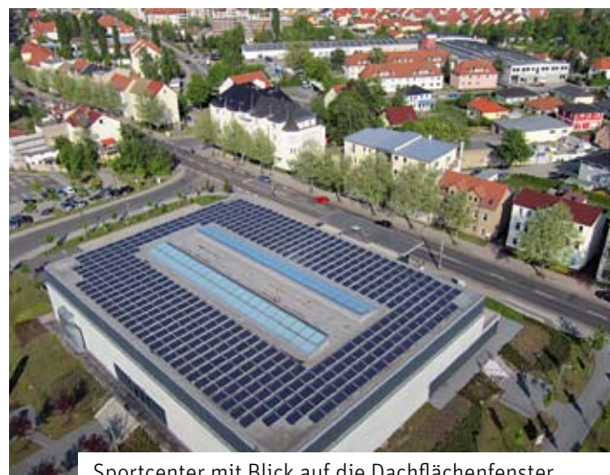
Sportcenter mit Blick auf die Dachflächenfenster
