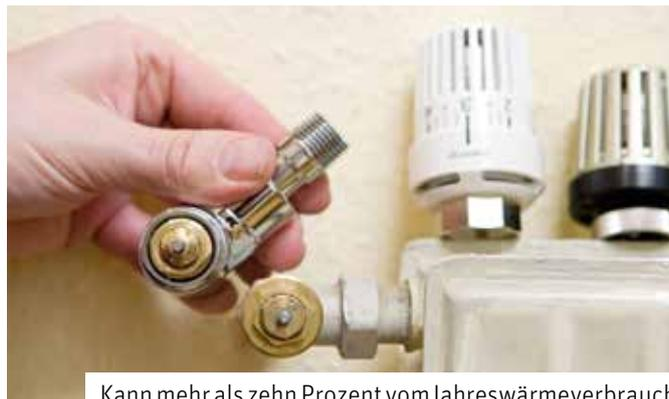
Kann mehr als zehn Prozent vom Jahreswärmeverbrauch ausmachen: Durch einen hydraulischen Abgleich lassen sich notwendigen Heizungswasser-Durchflüsse mit modernen Heizkörperventilen und einer neuen Pumpe exakt einstellen. (Foto: djd/ZVSHK)
