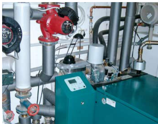
Einbau eines Blockheizkraftwerkes zur Verringerung der Umweltbelastung und Verbesserung der Wirtschaftlichkeit
